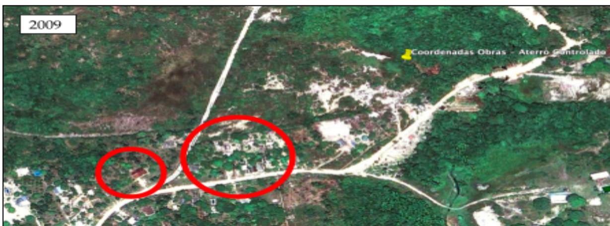
Figura 5. Residências consolidadas desde 2009 antes das obras do “novo aterro sanitário” (coordenadas geográficas: 2°57'42.01"S, 60°00'34.79"W). Fonte: Google Earth (outubro de 2009).
