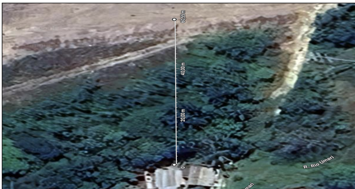
Figura 13. Distância aproximada de 60 metros entre os núcleos populacionais e as obras do novo aterro, bairro Lago Azul, Manaus. Fonte: Google Earth (agosto de 2025).
